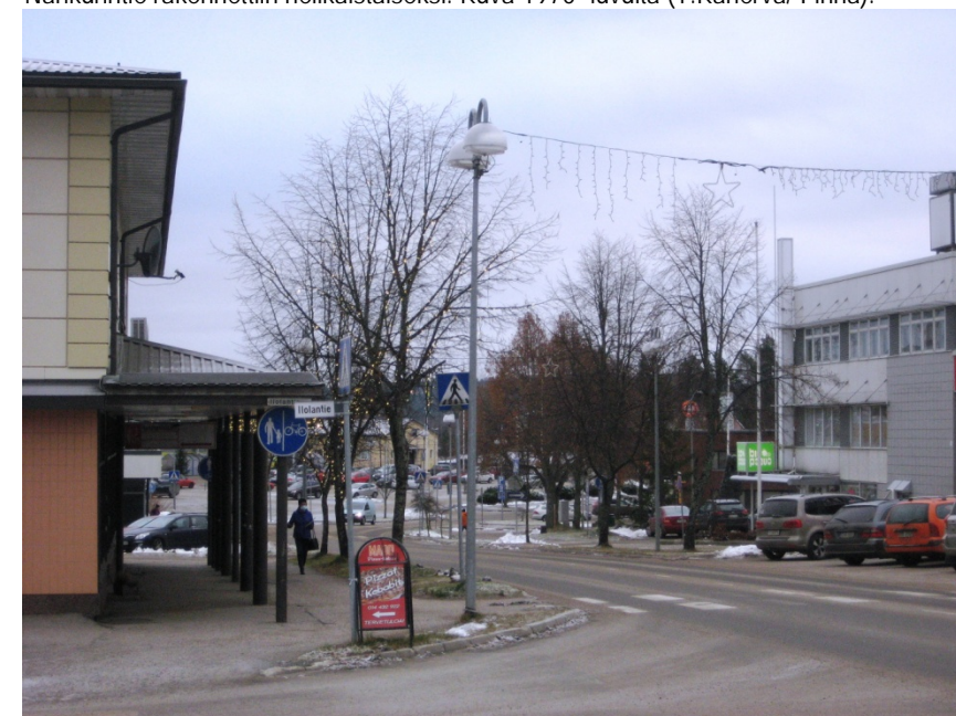
Kauppakatua vuonna 2020. Oikealla Säästökeskuksen kulmaa, vasemmalla korotettu Liikekulman rakennus. Kauppakatu on muutettu kaksikaistaiseksi, kevyt liikenne on erotettu viherkaistalla ja puita on istutettu.
