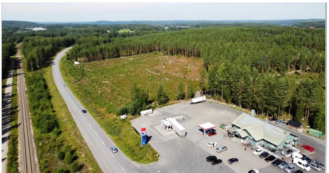
Kuva 6. Linnan yritysalue ennen valtatieliittymän siirtoa ja maanrakennustöiden aloittamista. Kuvan etualalla Kahvila-ravintola Linnan Liisa ja automaattitankkausasema.
