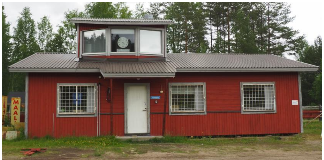
Kuva 7. Vanha huoltorakennus, jonka tilalle uusi huoltorakennus on tarkoitus rakentaa.
