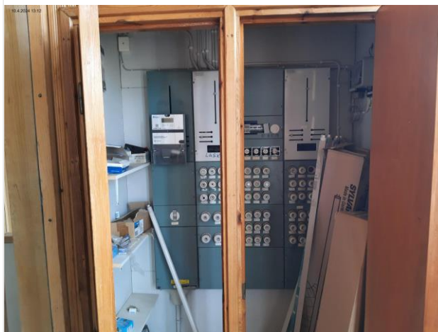
Kuva 134 Sähköpääkeskus
