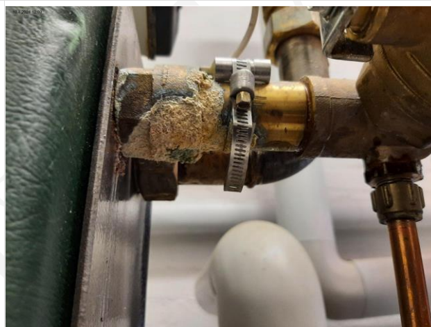
Kuva 107 Liitoksissa hapettumaa
