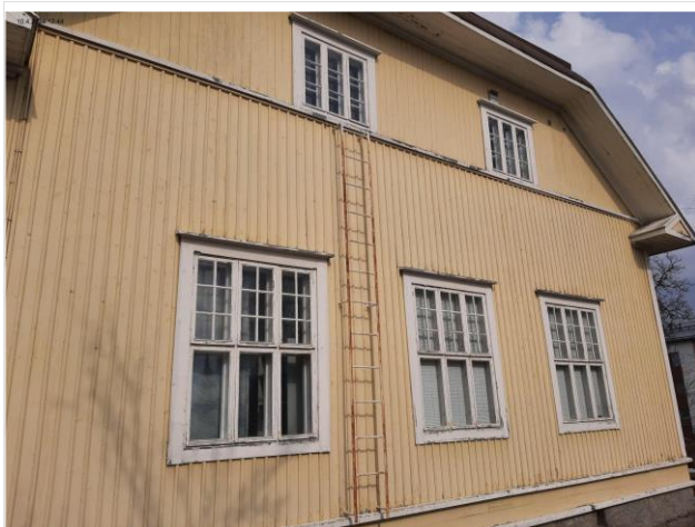
Kuva 59 Hätäpoistumistiet puutteelliset
