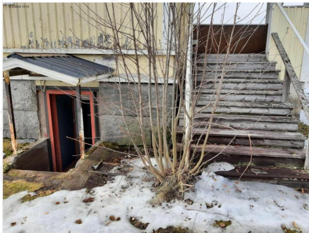
Kuva 12 Perusmuurin vierellä kasvillisuutta
