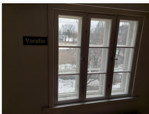
Kuva 54 Hätäpoistumistie puutteellinen
