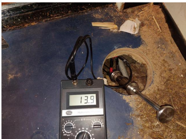
Kuva 13 Piikkimittaus alapohjan puurakenteista
