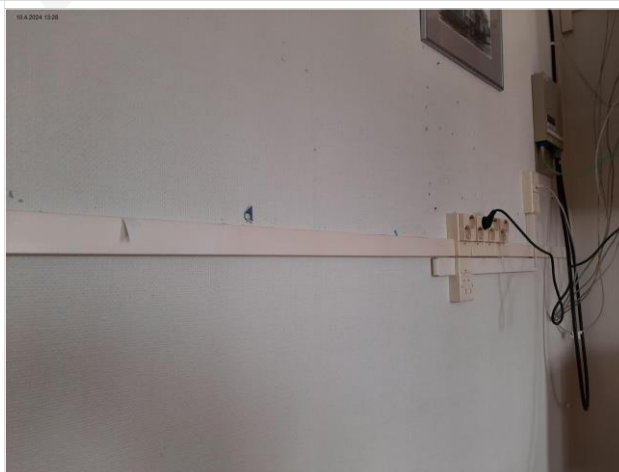
Kuva 132 Muovisia johtokouruja
