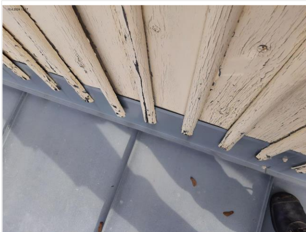
Kuva 73 Seinälle nostetun rintataitepellityksen yläreuna ei ollut tiivis
