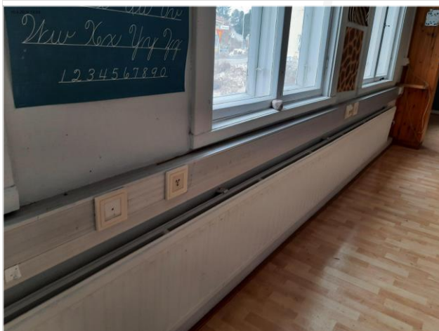
Kuva 131 Alumiinisia johtokanavia
