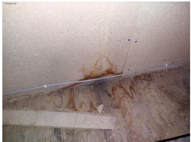
Kuva 42 Vuotojälkiä sivu-ullakolla
