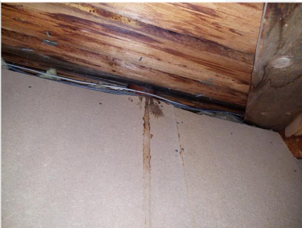
Kuva 41 Vuotojälkiä sivu-ullakolla
