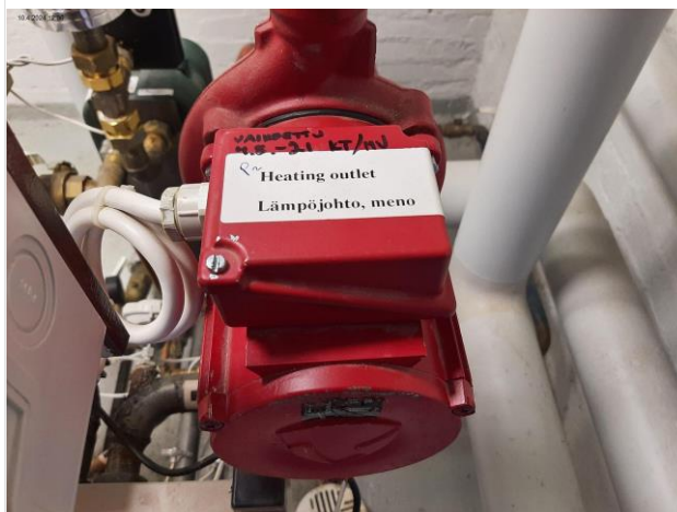
Kuva 112 Lämmityksen kiertovesipumppu
