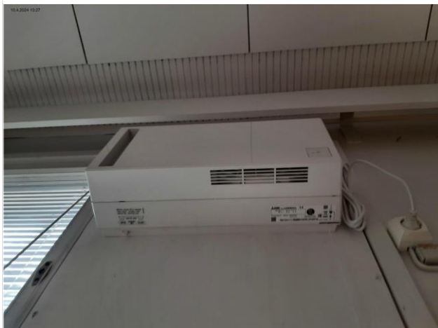
Kuva 125 Toimistotilassa Mitsubishi Lossnay vetonarumalli
