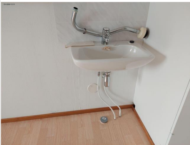
Kuva 117 Vesipiste poistettu käytöstä
