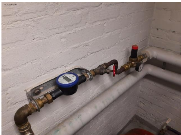
Kuva 111 Vesimittarin tarkastus
