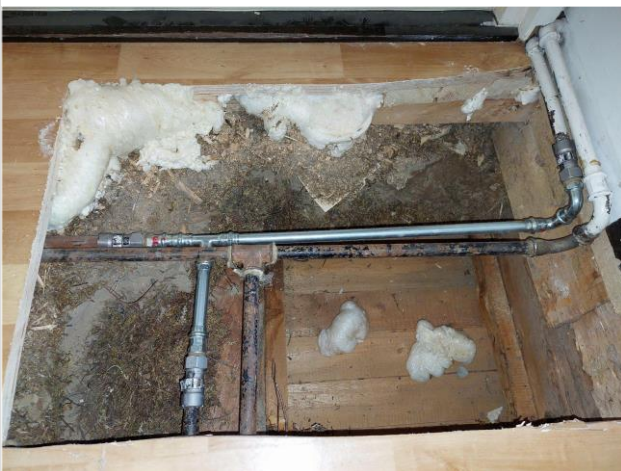
Kuva 33 Välipohjan rakenneavaus
