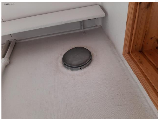
Kuva 129 Korvausilmaventtiili
