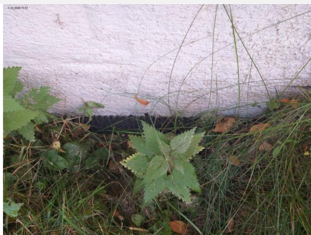
Kuva 7 Perustusten vesieristys havaittiin
