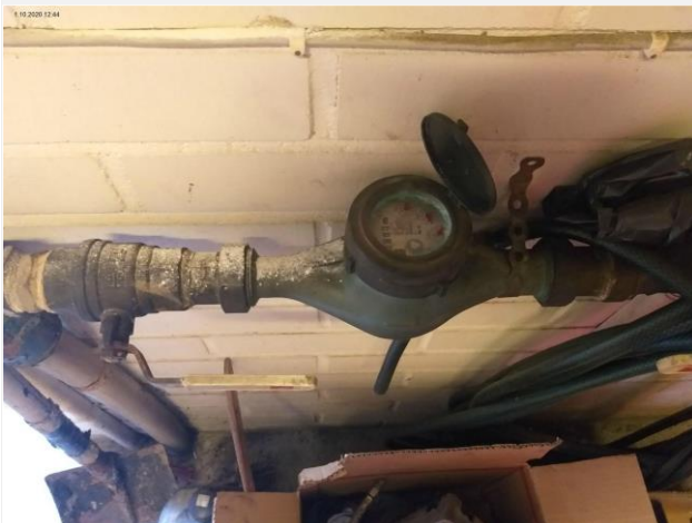
Kuva 51 Vesimittarin tarkastus
