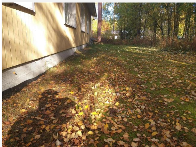
Kuva 6 Maanpinnan kallistukset olivat puutteelliset
