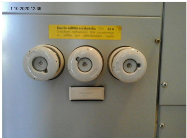
Kuva 71 Pääsulakkeet 3x63A
