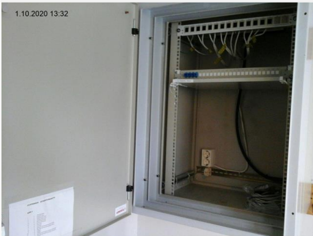
Kuva 89 Lähiverkon kytkentäkaappi
