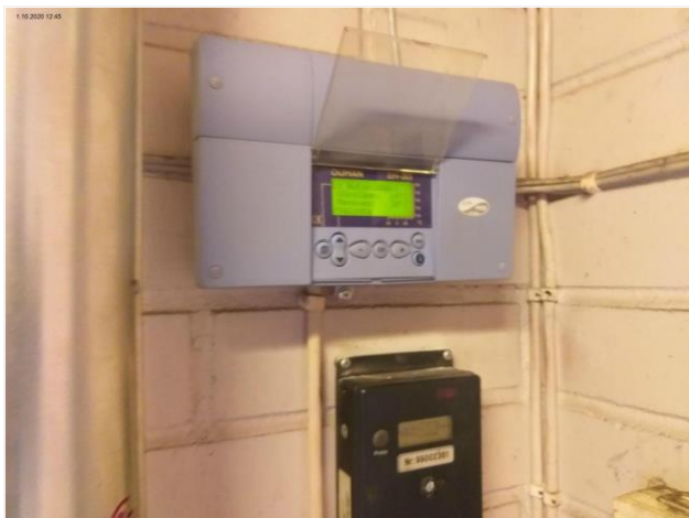
Kuva 49 Uusittuja ohjauslaitteita
