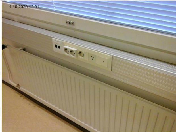
Kuva 81 Pistorasioiden jakelukisko
