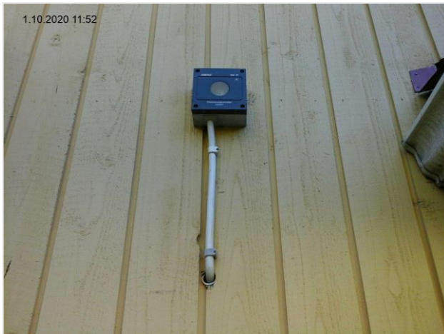
Kuva 86 Ulkovalaistuksen hämäräkytkin
