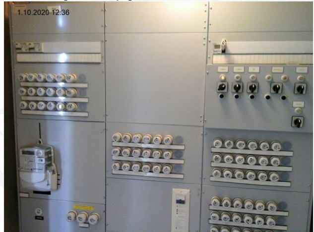
Kuva 69 Päävarokkeet 3x63A
