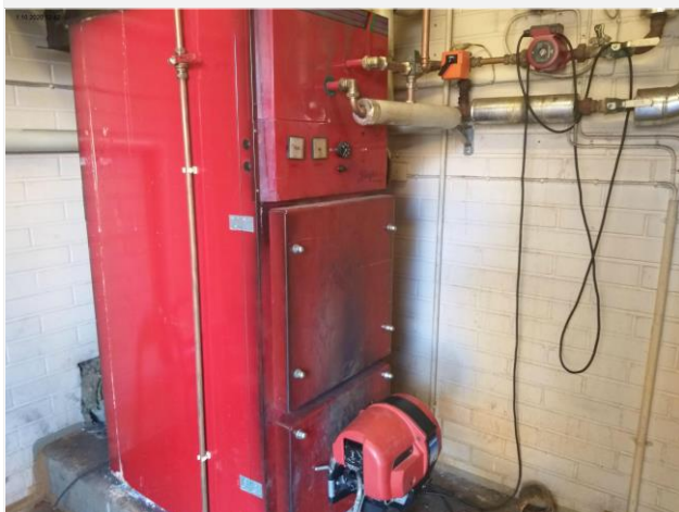
Kuva 47 Alkuperäinen öljylämmityskattila
