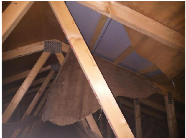
Kuva 16 Uusi aluskate asennettu vanhan päälle
