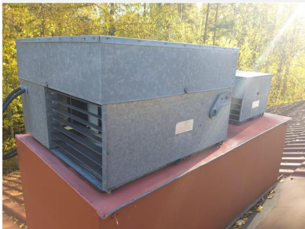
Kuva 58 Alkuperäinen huippuimuri vuodelta 1987
