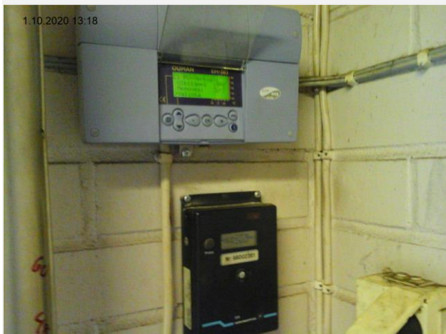
Kuva 93 Lämmönohjausyksikkö
