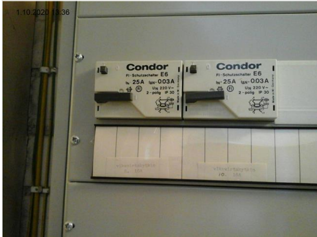
Kuva 80 Sähköpääkeskuksen vikavirtasuojakytkimet
