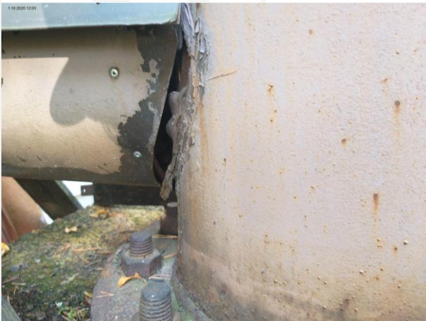
Kuva 15 Hormin liitos irti
