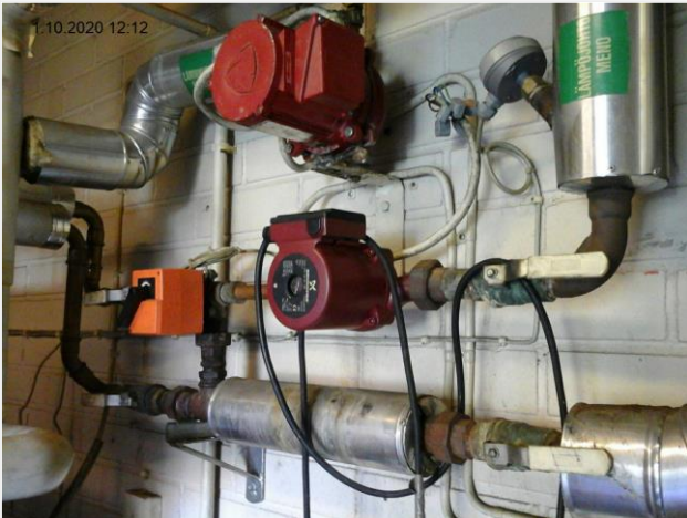
Kuva 74 Kiertovesipumppujen sähkökytkennät
