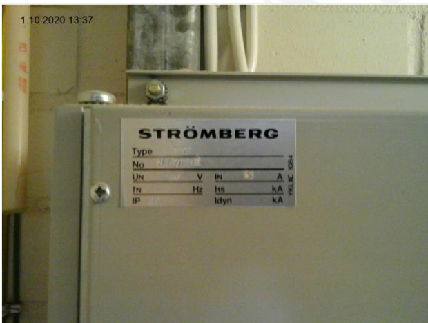
Kuva 70 Sähkökeskuksen tyyppikilpi
