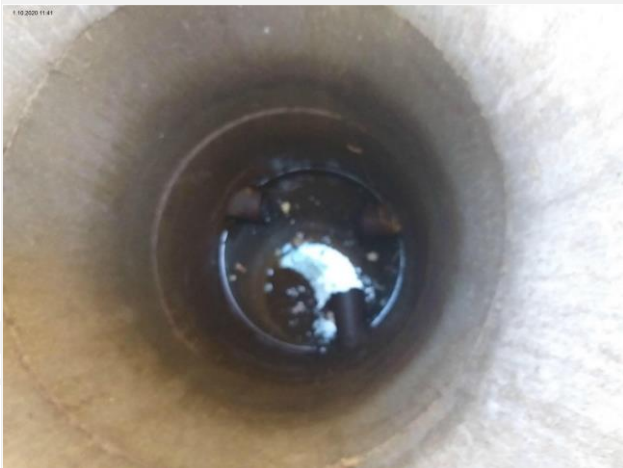
Kuva 2 Salaojajärjestelmän tarkastus
