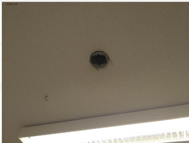
Kuva 59 Poistoilmaventtiili puuttui
