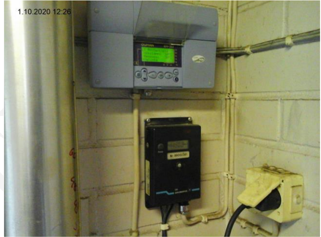
Kuva 77 Lämmönohjausyksikkö
