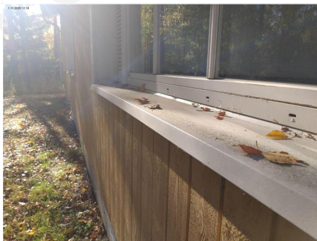
Kuva 20 Ikkunoiden vesipeltien kaltevuus vähäinen
