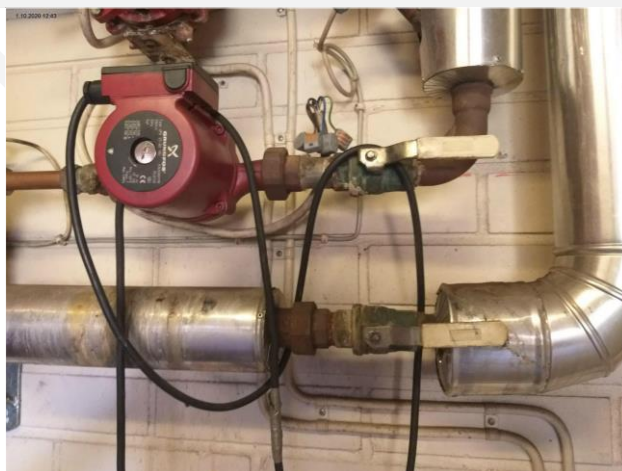
Kuva 48 Uusittu kiertovesipumppu
